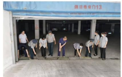
汛沙袋并放置于地下车库、机房门口等重点位置，对雨水井、楼顶排水口进行清理及疏通，检查地下车库抽水泵运行状态，确保雨水井、排水沟、水泵等相关设施的正常运行，切实保障暴雨期间排水设备有序排水。
